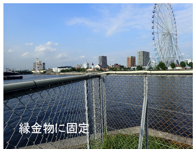
写真-B.6 ケーブル保護 (敷地フェンスに設置)
