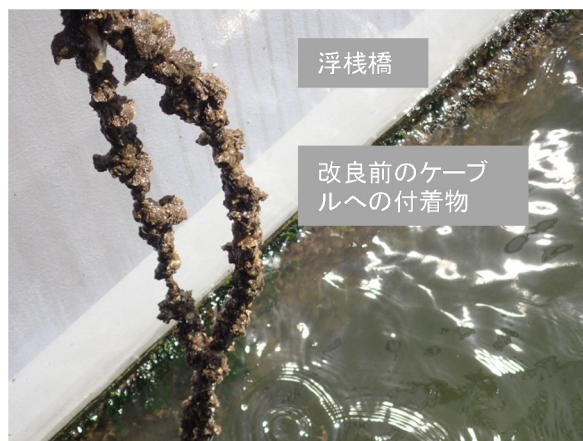
図-4.1 潮間帯部ケーブルへの付着物 (改良前)
