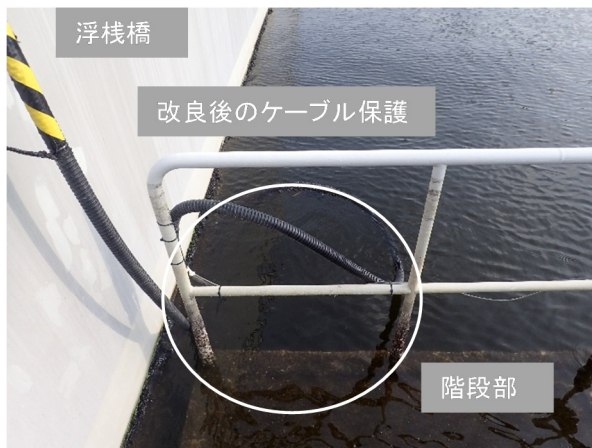
図-4.2 潮間帯部のケーブル保護
