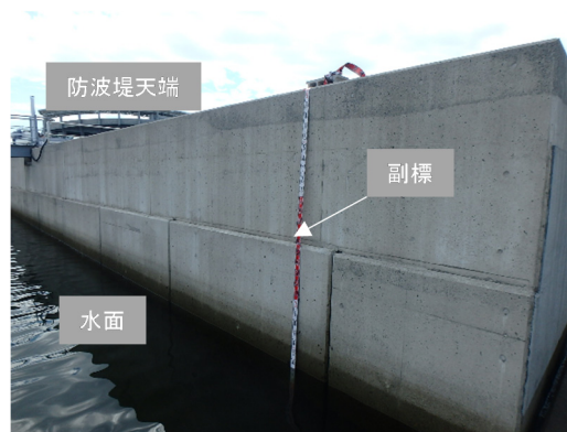
図-3.1 海水面の測定（港内側）
