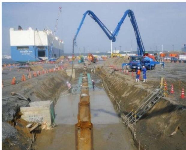
写真7.10 クレーン基礎杭部の復旧
