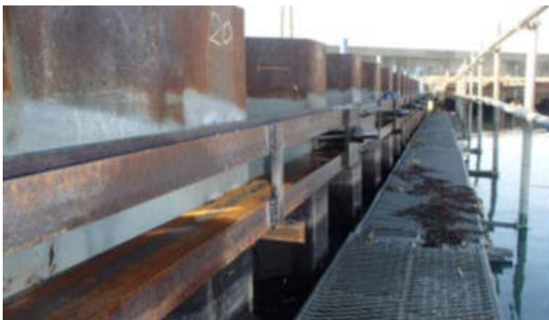
図-4.28 腹起（筆者担当工事で撮影，2014 年）
