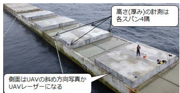
図-4.34 上部コンクリート（筆者撮影，2016 年）
