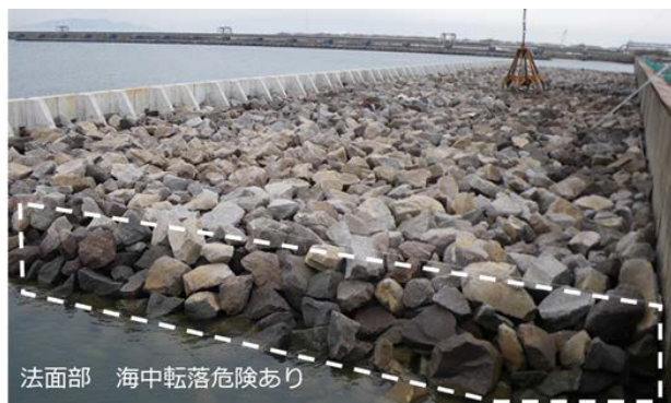
図-4.18 裏込工陸上部状況（筆者撮影，2011 年）
