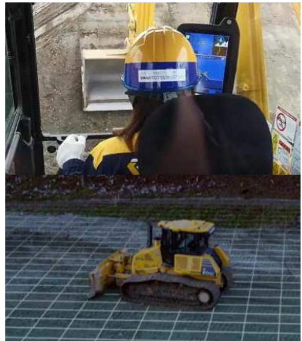
図-2.8 ICT 建設機械による施工 15)
