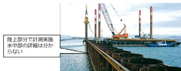
図-4.26 鋼管矢板打設状況 53)
