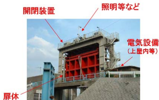
図 3-1 水門の構成部材の例
