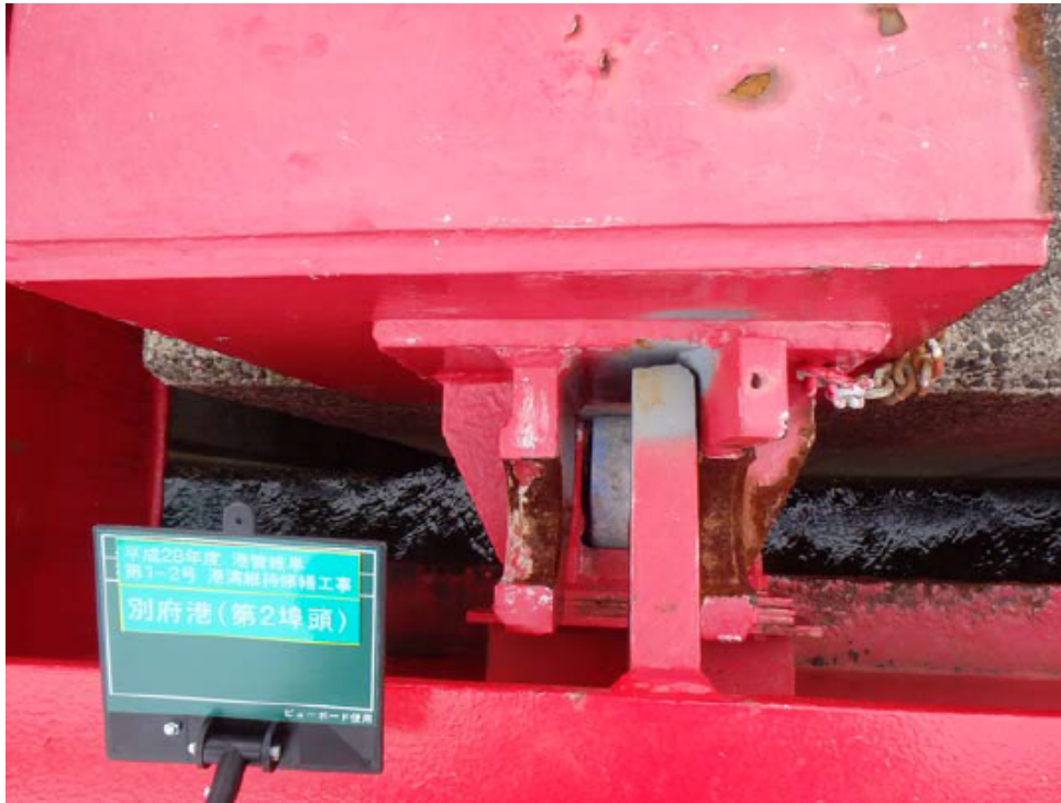
写真-5.10 可動橋右側のフックとブラケットの間の干渉
