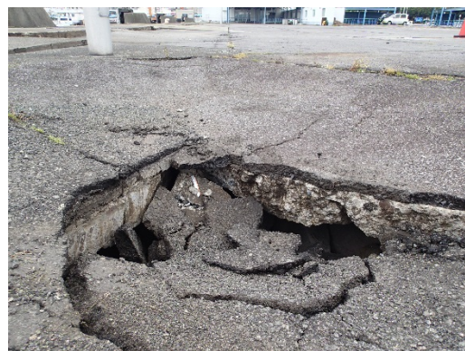
写真-5.8 石垣地区第二埠頭岸壁（-5.5m）南東側の隅角部での吸出しによる陥没（2016年4月18日撮影）
