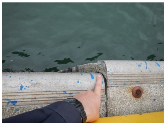
写真-6.5 上部工のずれ
