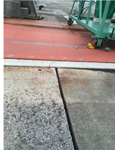
写真-5.5 石垣地区第二埠頭岸壁（-5.5m）北側の目地の開き（2016 年 4 月 18 日撮影）
