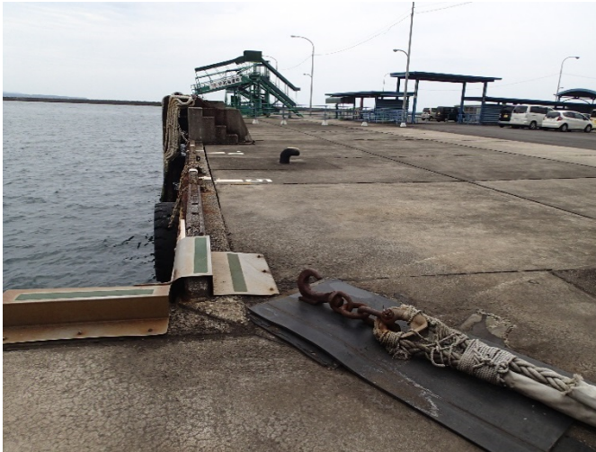
写真-5.5 石垣地区第二埠頭岸壁（-5.5m）北側の目地の開き（2016 年 4 月 18 日撮影）
