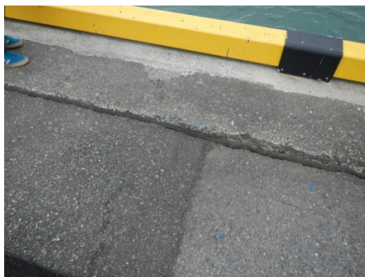
写真-6.8 アスファルト舗装の補修跡
