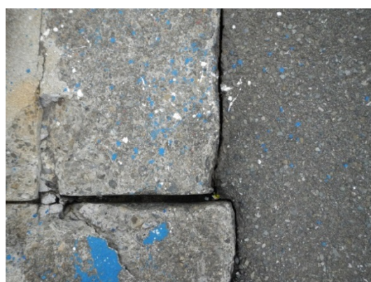
写真-6.6 上部工ずれ位置の背後にある補修跡
