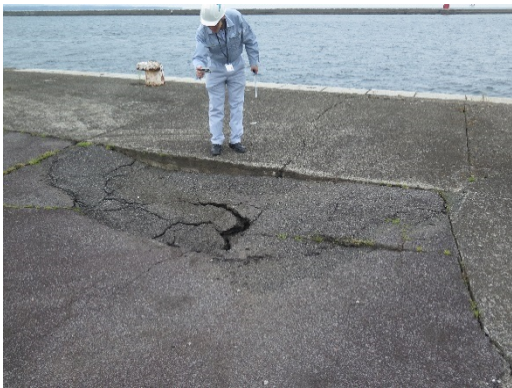
写真-5.8 石垣地区第二埠頭岸壁（-5.5m）南東側の隅角部での吸出しによる陥没（2016年4月18日撮影）
