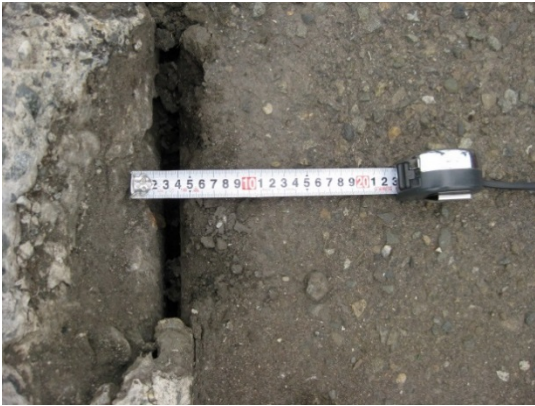
写真-6.1 鋼管矢板の上部工背後の開き
