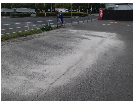
写真-5.3 石垣地区第三埠頭岸壁（-12m）エプロン背後の駐車場での3箇所の液状化痕（2016年4月18日撮影）
