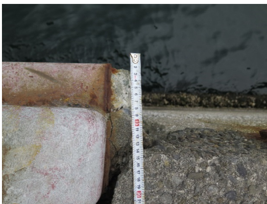
写真-5.4 石垣地区第三埠頭岸壁（-12m）側面護岸における護岸法線のずれ（2016年4月18日撮影）
