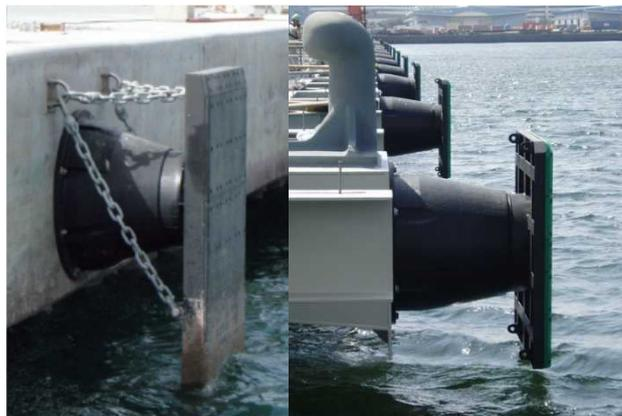
図-2.2 円錐型防舷材(受衝板付)の例（同左）
