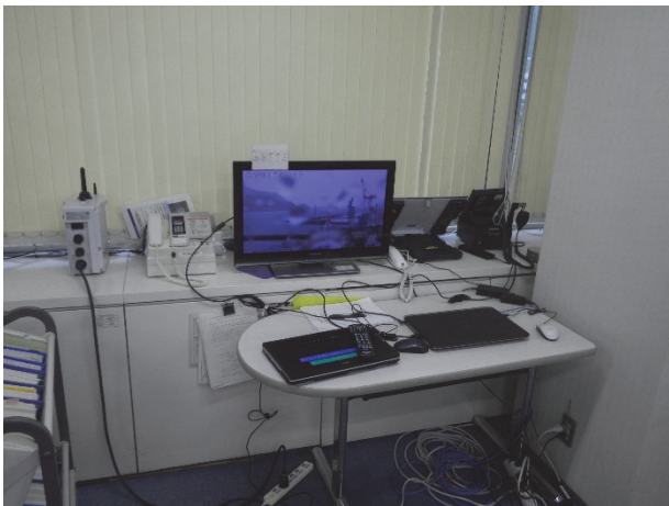
機器設置状況(釜石港湾事務所)
