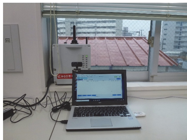
図 7-4 実証試験の様子（港湾事務所：被災地）
