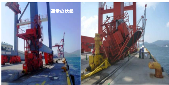
(a) 通常の状態 (b) 損傷後の状態
