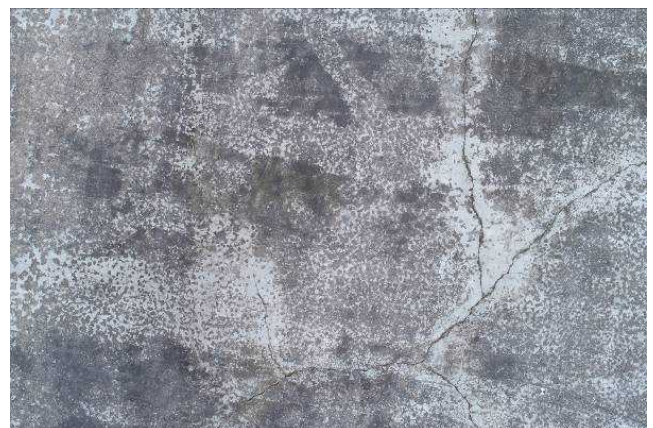
図-B.6 下崎北防波堤（近接）
