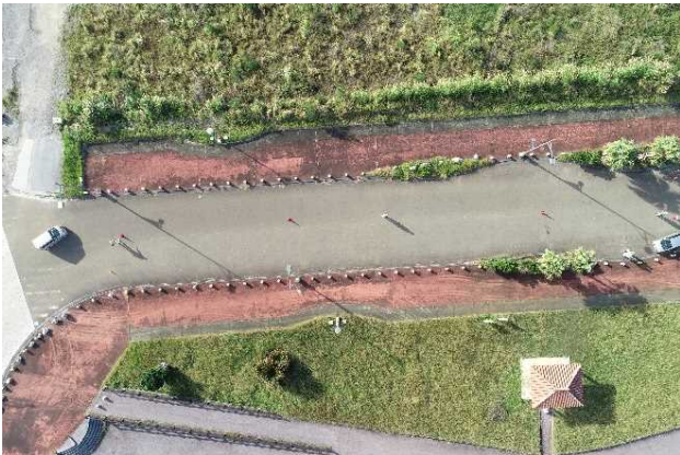
図-B.1 臨港道路マリーナ線（全景）
