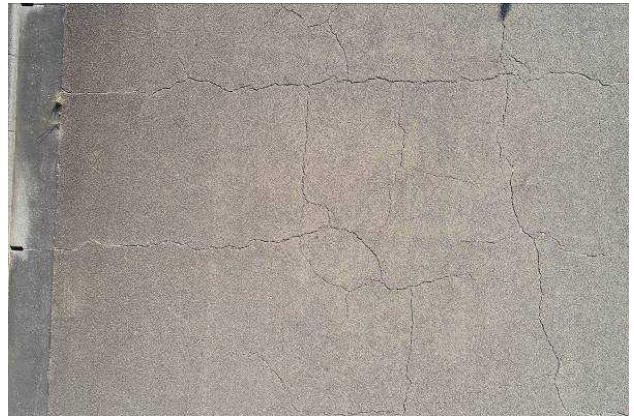
図-B.2 臨港道路マリーナ線（近接）
