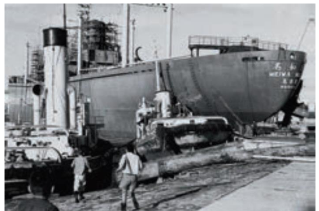
写真2.3 名古屋港での船舶乗り上げ被害 （出典：名古屋港管理組合HP）
