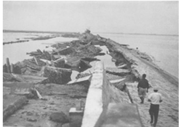
写真2.2 半田武豊海岸での被害 （出典：三河港湾事務所HP）
