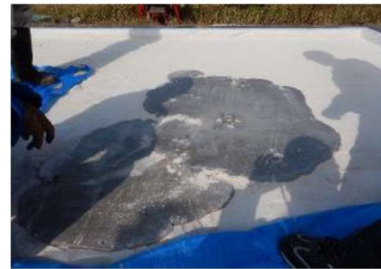
⑦ 40分養生後の樹脂確認
