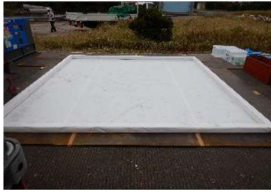
① 防火シート敷設
