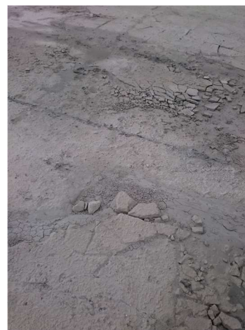
写真-1.1 既設PC版を撤去し露出させたグラウト層
