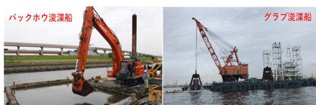
図-1.1 バックホウ浚渫船とグラブ浚渫船
