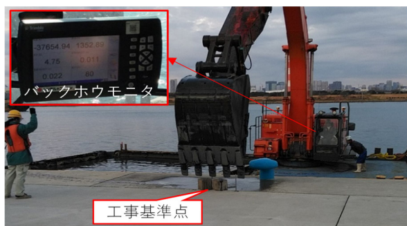
図-2.9 バケット位置精度の確認事例
