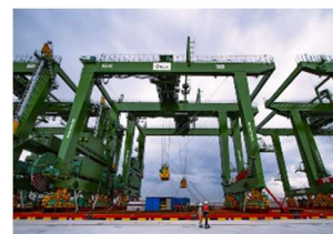
図-5 Tuas に納品された遠隔操作 RTG
