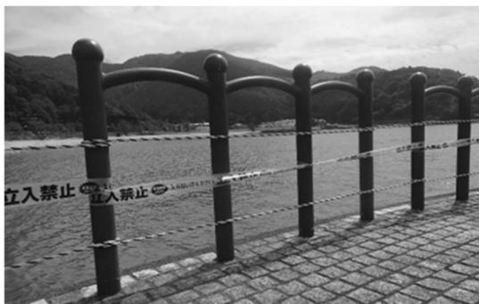
トラロープによる隙間処理（横柵形式）
