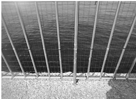
ネットによる隙間処理（縦柵形式）
