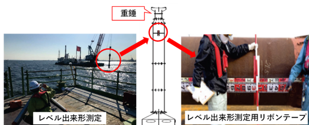
図-2.6 捨石高さレベル出来形測定
