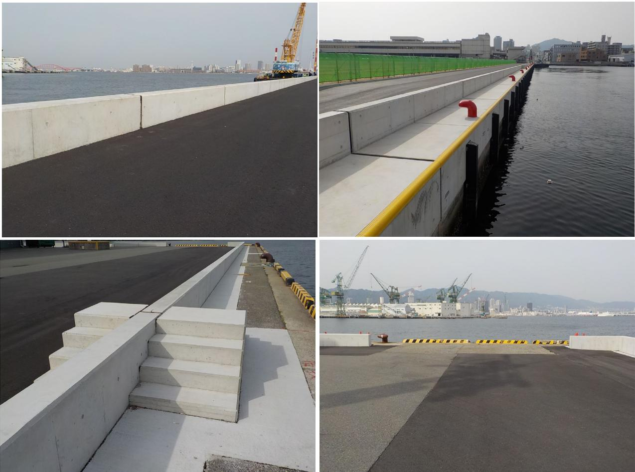
写真-5.2.1 兵庫埠頭での防潮壁設置状況
