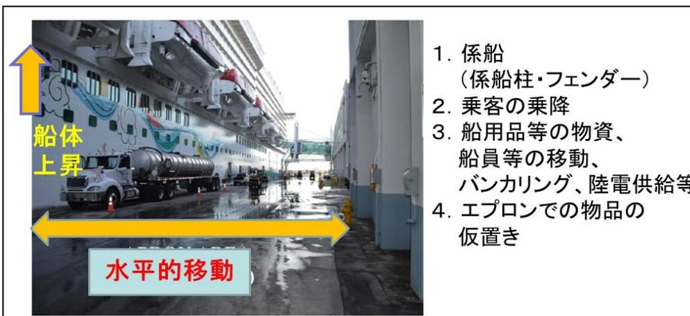
図-2.2.2 クルーズ船の着岸状況とインターフェース機能
