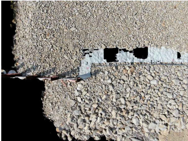
(a)O 港（中央の浸透防止シートが海と推定されて除去）
