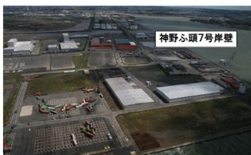
写真-A.2.1 被災状況写真 1) （三河港神野ふ頭7号及び8号岸壁）
