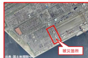
写真-A.2.9 被災状況写真 7) (川崎港・東扇島地区)
