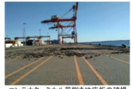
コンテナターミナル荷崩き地板の破損
