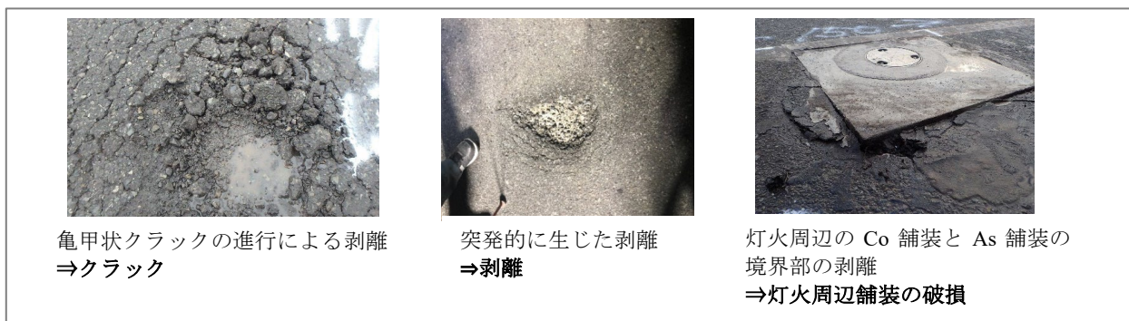
図-2.3 変状の種類の判断の例
