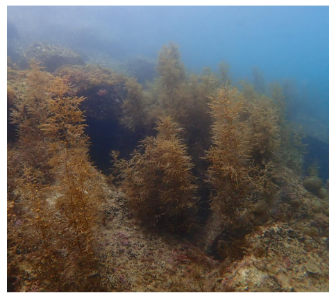
海藻が繁茂した港湾構造物
