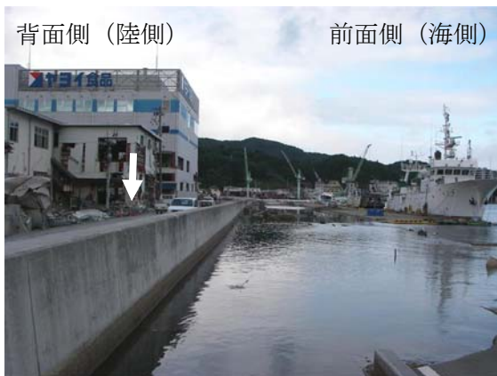
写真-12 被害のない胸壁 (気仙沼漁港浜町地区)
