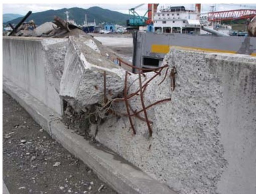
(2) 欠損部分 (西側) の拡大写真
