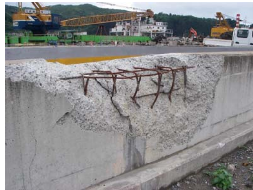
(3) 欠損部分 (東側) の拡大写真
