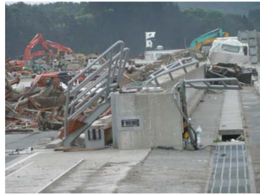
(2) 陸閘の付帯設備の被害
