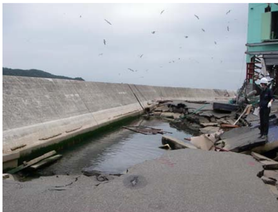
写真-7 天端被覆工の陥没 (地点 e)
