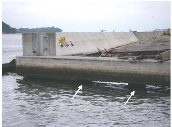
(4) 露出している基礎杭
