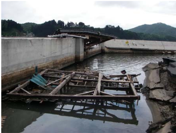
(3) 背面側（陸側）からみた状況
