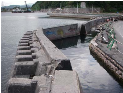
(1) 前面側 (海側) に変位した護岸
