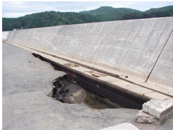
写真-6 天端被覆工の陥没 (地点 d)
