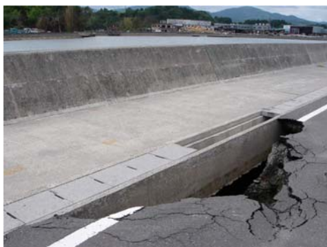
写真-10 背後側舗装の陥没 (地点 g)
