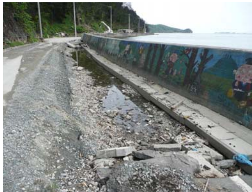
写真-14 背後側地盤の洗掘 (地点 j)
