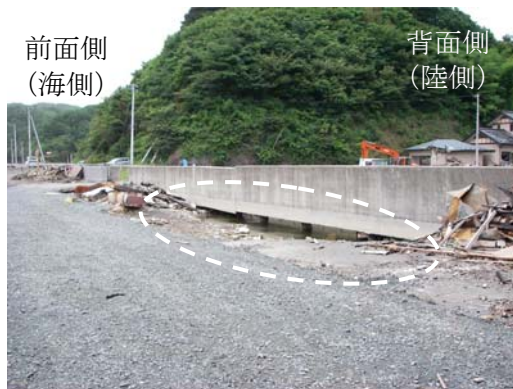
写真-15 胸壁の堤体直下の地盤の流出（地点 k）
