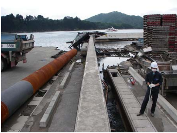
(1) 地盤流出の状況
