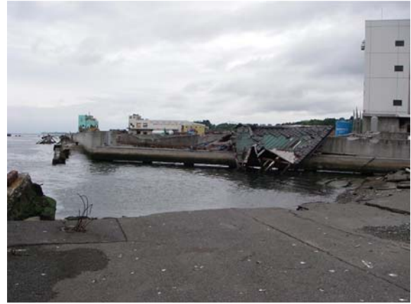
(2) 前面側（海側）からみた状況
