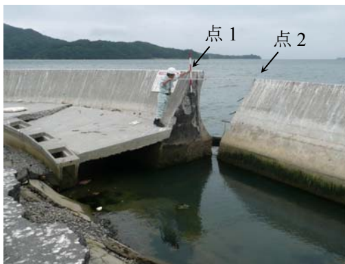
(3) 倒壊していない部分の天端高さの測定
