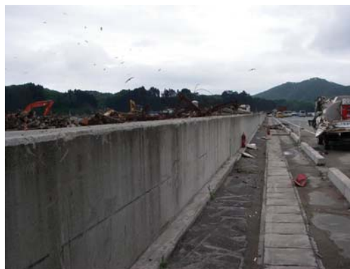
写真-3 地点 b~c の区間
