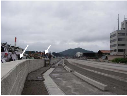
(1) 胸壁の堤体 (ほとんど被害なし)
