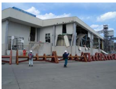
写真-6 出崎地区の建物被災
