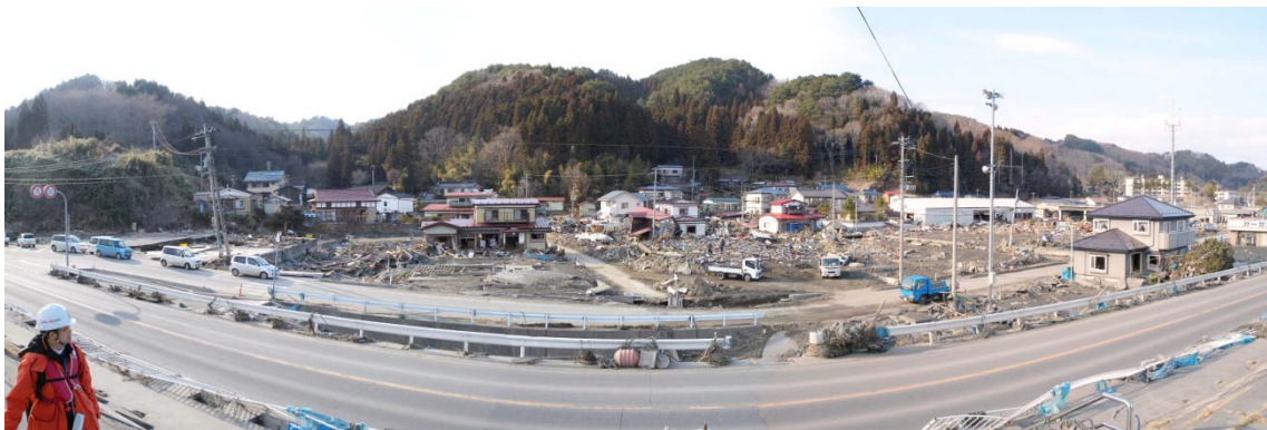
写真-13 高浜地区の被災状況
