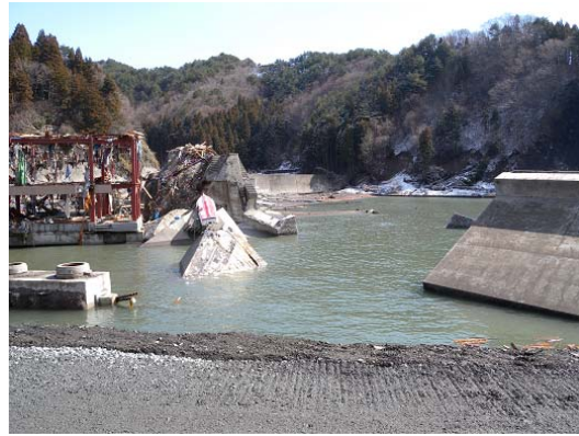
写真-2 両石地区防潮堤の被災
