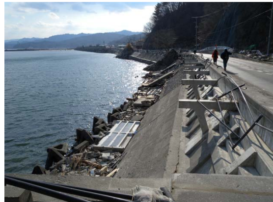
写真-10 高浜地区の遊歩道の破壊
