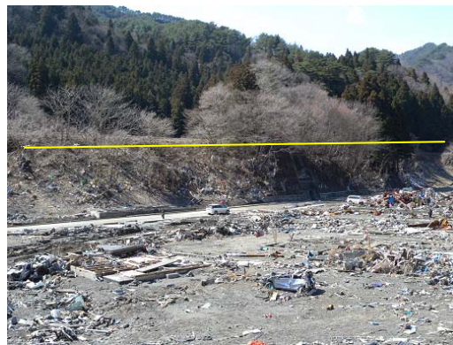
写真-3 斜面の同じ高さに残る津波漂流物
