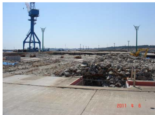
写真-10 常陸那珂港 ケーソンヤード
