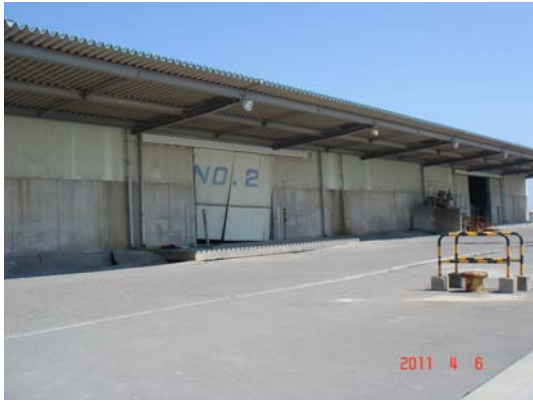
写真-12 日立港第二埠頭地区 県営2号上屋
