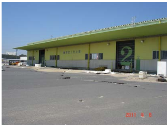
写真-9 常陸那珂港 県営1号上屋
