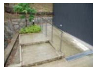
心身特性に応じた玄関アプローチの改修
