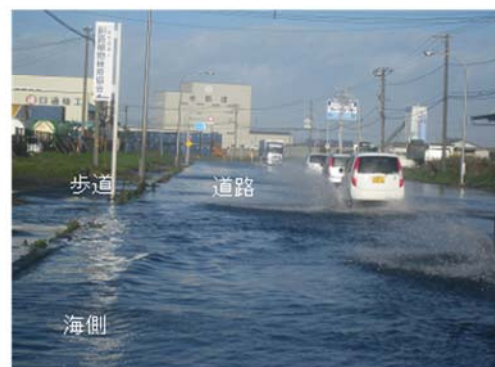
写真2-3 臨港道路釧路西港道路西向き(10月2日6:50頃)
