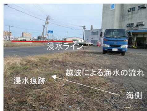
写真1-2 東港区北埠頭岸壁沿い道路(10月7日撮影)
