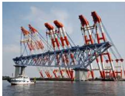
大型起重機船3隻相吊り作業管理システム(吊り荷重・高度・起重機船位置、トラス吊上時管理モニター等)を構築し、側径間トラスの大ブロックを架設
