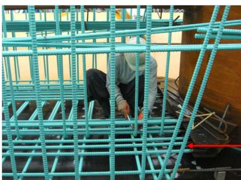
コンクリート構造部材の耐久性を向上させる方策としてエポキシ樹脂塗装鉄筋を適用
