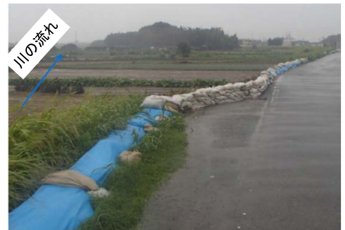
水防団による水防活動(土のう積み)
