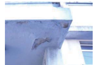
外装材のはがれ
