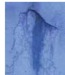
外装材のはがれ (多数回の改修歴がある場合)
