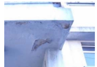
外装材のはがれ
