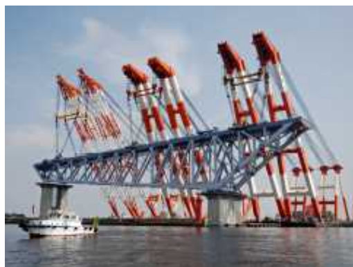
施工時の安全確保事例
