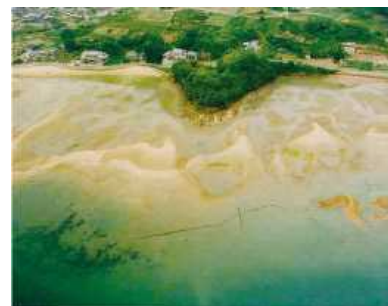
干潟造成: 浚渫土を有効活用して干潟を造成。生物の増加や鳥類の飛来など、自然と共存。
