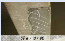
浮き・はく離
