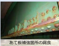
あて板補強箇所の腐食
