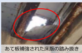
あて板補強された床版の踏み抜き
