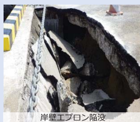
岸壁工ブロン陥没
