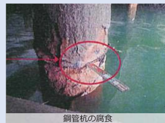
鋼管杭の腐食
