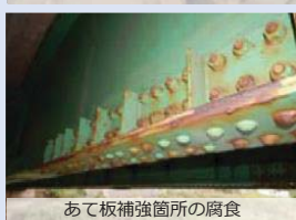
あて板補強箇所の腐食
