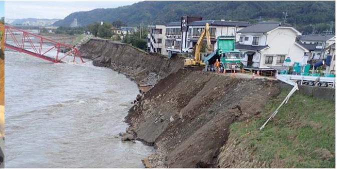
千曲川左岸104kp付近の堤防欠損状況
