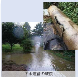
下水道管の破裂
