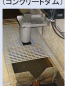
漏水量の監視
