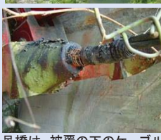
吊橋は、被覆の下のカブルの状態把握が期待される
