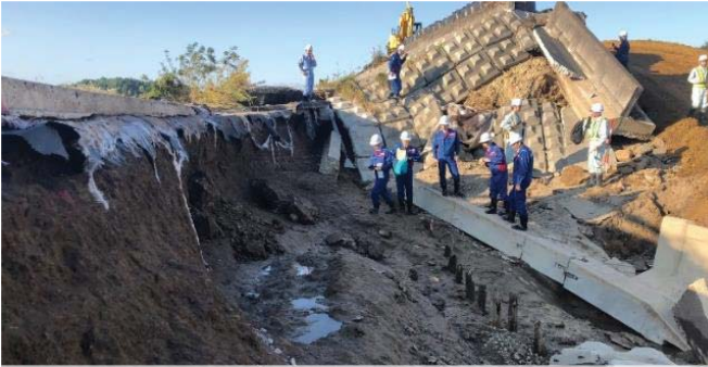
鳴瀬川水系吉田川左岸20.9kp付近の堤防決壊状況
