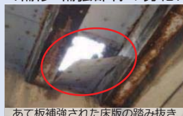
あて板補強された床版の踏み抜き
