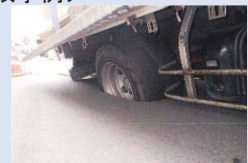
下水道管の破損による道路の陥没
