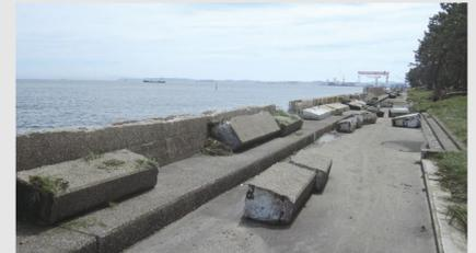
令和元年台風第15号の高波による護岸の被災
