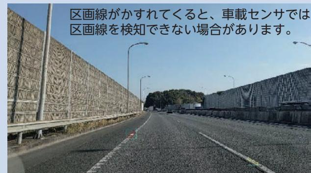
車線維持支援システム（LKAS : Lane Keep Assist system）：車載センサで区画線を読み取り、車線中央を走行するようにハンドル操作を自動で行うシステム
