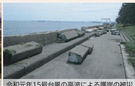
令和元年15号台風の高波による護岸の被災
