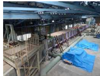
台風防災水路全体
