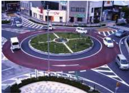
停電時でも安定して交通制御が可能なラウンドアバウト交差点の整備事例 (茨城県日立市)
