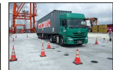
動的載荷試験実施状況
