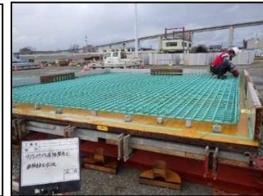
リプレイサブル床版製作状況
