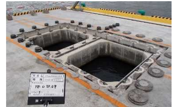
施工性確認試験実施状況(床版撤去)
