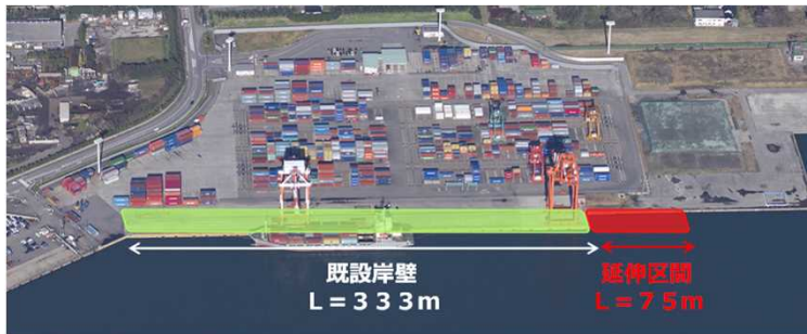
伏木富山港(新湊地区)岸壁12m
