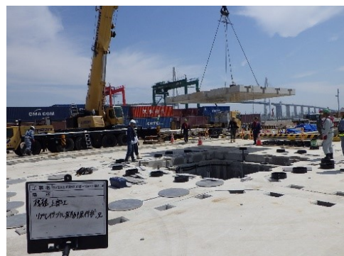
リプレイサブル栈橋の施工状況
