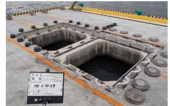
施工性確認試験実施状況(床版撤去)
