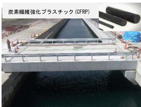
PC ホロー桁の施工状況（右上：CFRP）
