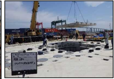
床版の設置状況
