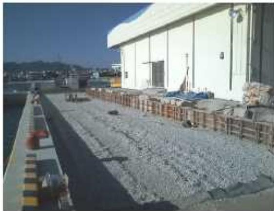
出典)「施工事例:岸壁の裏込材にL4を使用した事例」
