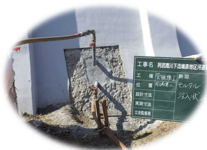
モルタル充填状況
