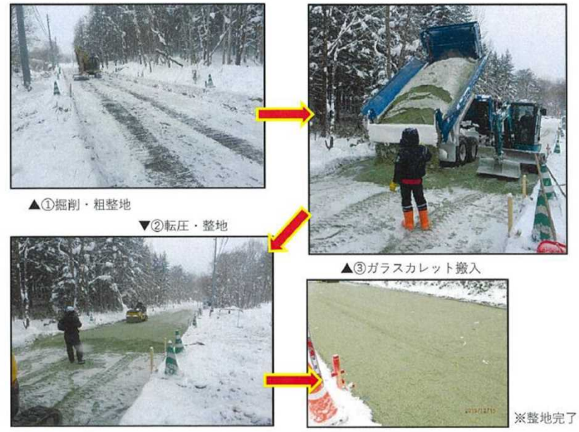
出典)「ガラスカレット施工事例集」(コンスAMG(株))
