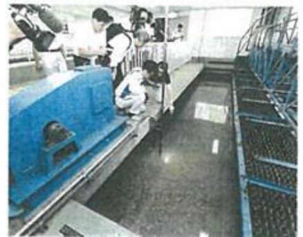
集中豪雨に伴う浄水場の機能低下による断水事例
