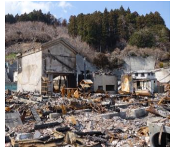
林野火災による建物被害の例
