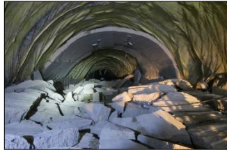
（トンネル内部の覆工崩落例）
