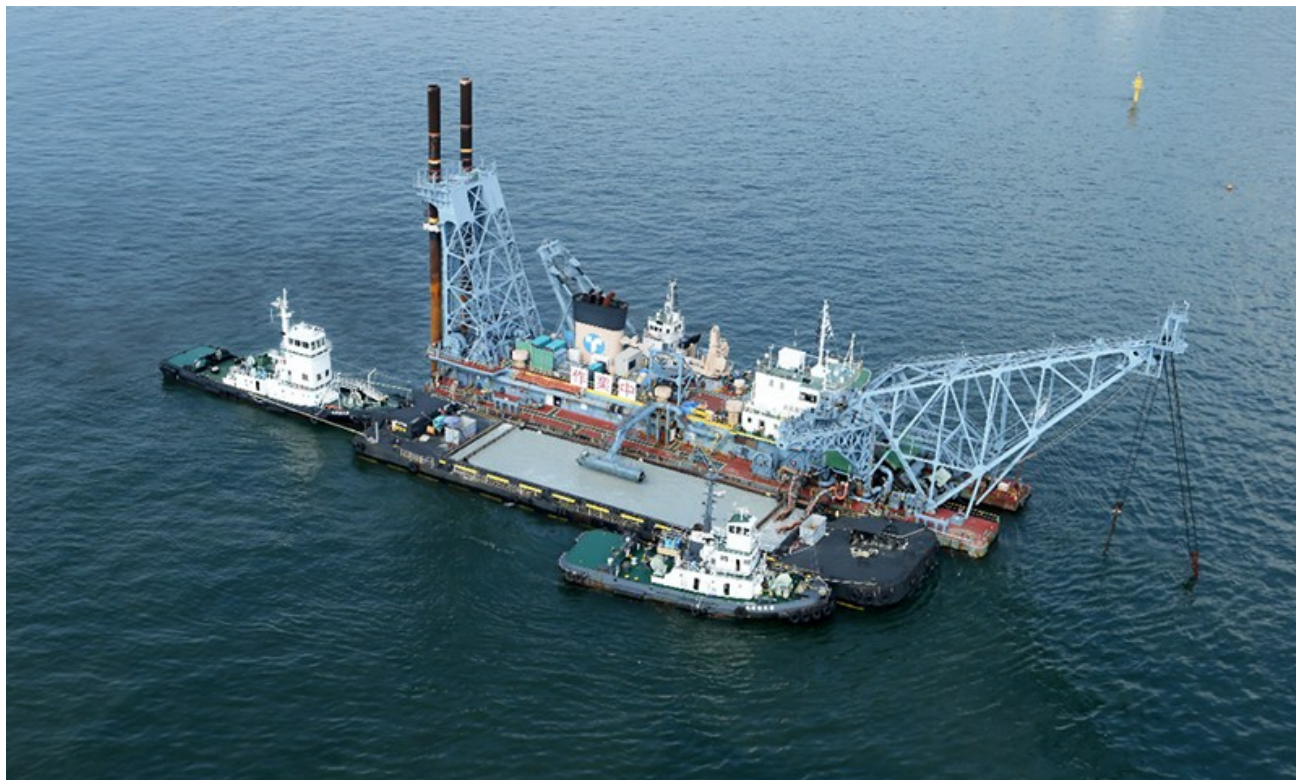
作業船を用いた浚渫工事
