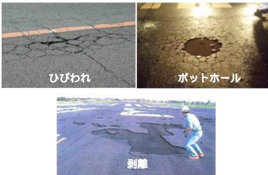
【空港舗装の損傷事例】
