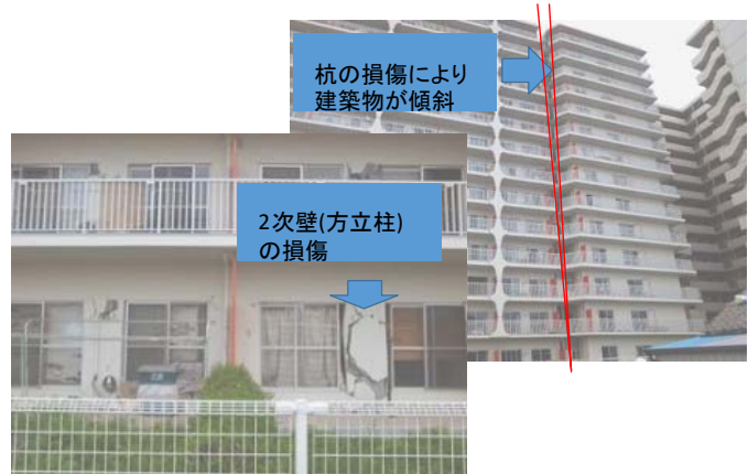
東日本大震災での被害例 柱、梁の被害は軽微であるが、取り壊しとなっている
