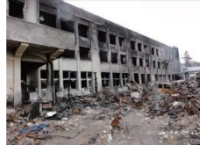
地震誘発火災被害例
