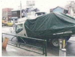
埋設管破損による道路陥没
