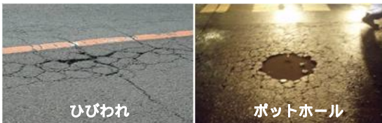
【空港舗装の損傷事例】
